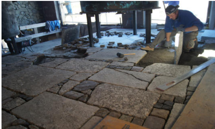
Granitboden wird gelegt
