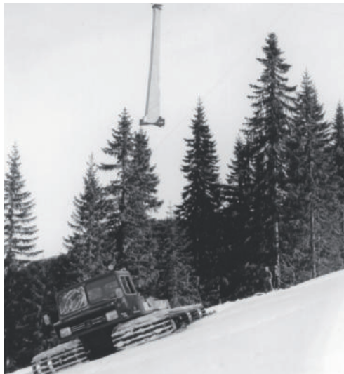
Stützenmontage mit Hubschrauber für die 2. Sektion 1973
