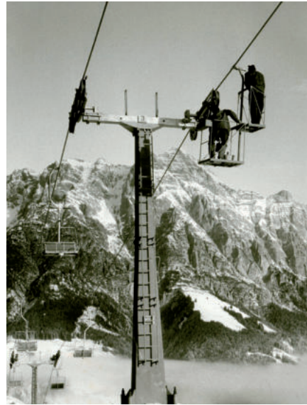
Rollenmontage Nov. 1972 auf der 1. Sektion
